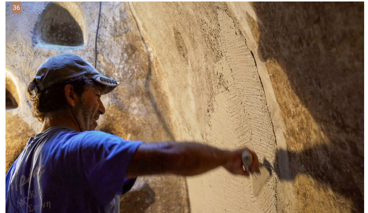
Εικ. 36| Πρώτη εφαρμογή του αλείμματος με μυστρί.(Φωτ: Γιώργος Κυβερνήτης)
