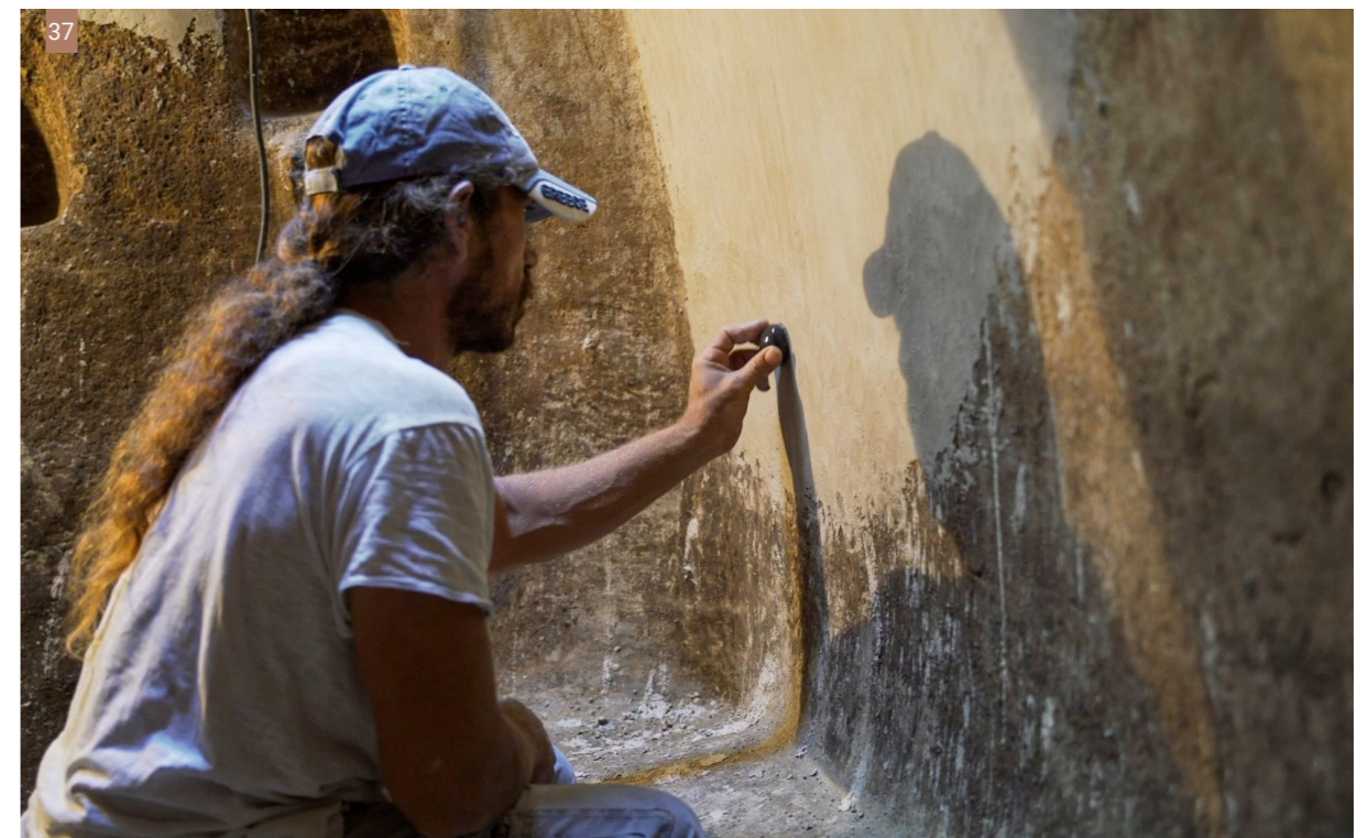
Εικ. 37| Επεξεργασία της τελικής στρώσης με το χοχλίδι, από τον Θηρασιώτη μάστορα Χαράλαμφο Συρίγο. (Φωτ: Γιώργος Κυβερνήτης)
