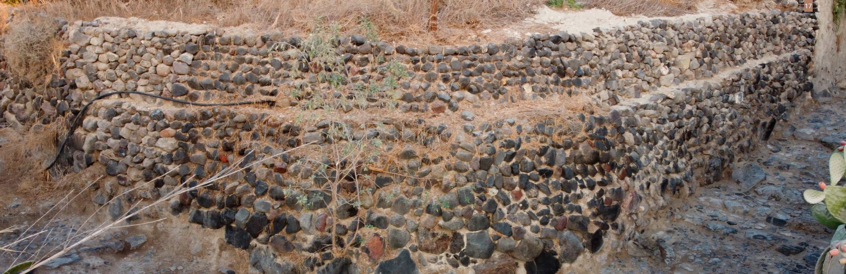
Εικ. 17| Ο αποκατεστημένος τοίχος αντιστήριξης. (Φωτ: Γ. Κουτρόπουλος)
