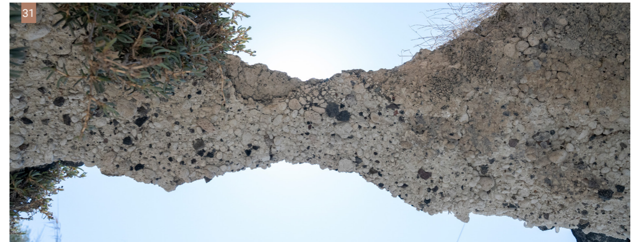
Εικ. 30, 31| Θολωτή κατασκευή στην Αγριλιά, με το τοπικό σκυρόδεμα, το κισσηρόδεμα. (Φωτ: Π. Κωστούλας, Γ. Κυβερνήτης)
