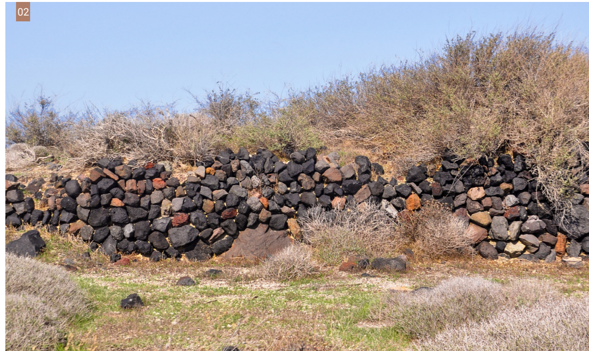
Εικ. 2| Διάφορα ηφαιστειακά πετρώματα χρησιμοποιούνται για την κατασκευή των ξερολιθικών τοίχων της υπαίθρου. (Φωτ: Α. Ζαχαράκη)
