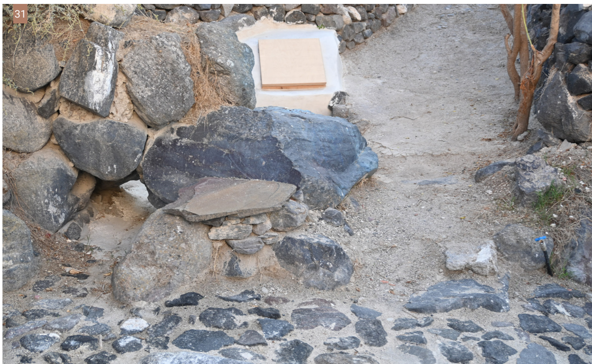
Εικ. 31| Λεπτομέρεια από τη διαμόρφωση της διόδου διοχέτευσης του νερού στην υπέργεια επιφάνεια συλλογής της στέρνας Β. (Φωτ: Γ. Κυβερνήτης)
