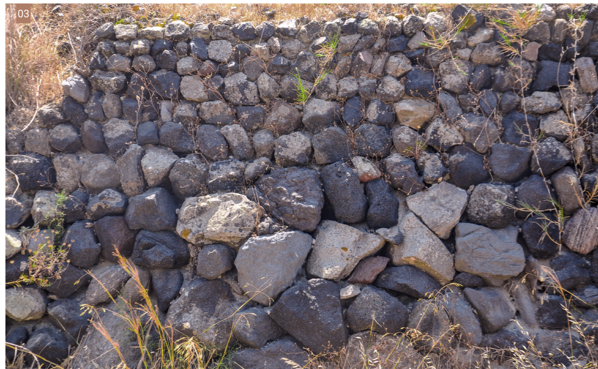
Εικ. 3| Συχνά παρατηρείται η χρήση μεγαλύτερων λίθων στη βάση ενός ξερολιθικού τοίχου. (Φωτ: Α. Ζαχαράκη)
