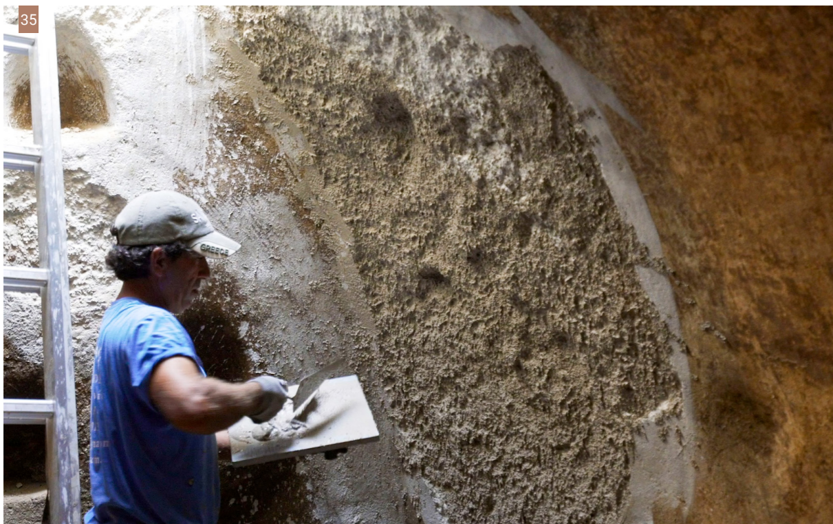
Εικ. 35| Το πεταχτό εφαρμόζεται με δύναμη από τον Θηρασιώτη μάστορα Γιώργο Κρεβατά (Φωτ: Γιώργος Κυβερνήτης)
