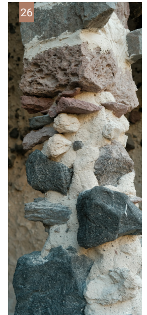
Εικ. 24, 25, 26| Λεπτομέρειες υπόσκαφων κατασκευών. Η δόμηση στηρίζεται στο ισχυρό κονίαμα άσπας-ασβέστη και επιτρέπει λιγότερη επιμέλεια στο χτίσιμο της πέτρας. (Φωτ: Ι. Ντούτση)
