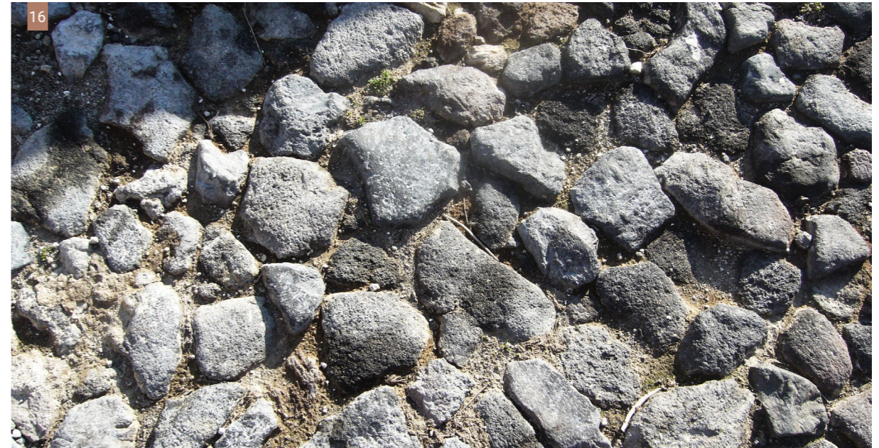
Εικ. 14, 15, 16| Απόψεις του μονοπατιού που οδηγεί στο λιμάνι του Κόρφου από τη χώρα τον Μανωλά στη Θηρασιά: διακρίνονται οι βαθμίδες του μονοπατιού και η τεχνική του πλακωτού. Αν και το παραδοσιακό πλακωτό διατηρούνταν σε καλή κατάσταση, το μονοπάτι λιθοστρώθηκε εκ νέου με χρήση ταιμέντου την τελευταία πενταετία. (Φωτ: Κατερίνα Ριτζούλη)
