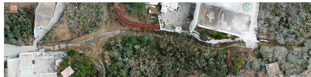
Εικόνα 5| Υπόδειξη της θέσης του βόρειου τοίχου αντιστήριξης που αποκαταστάθηκε σε σχέση με το κεντρικό μονοπάτι. (Ορθοφωτοχάρτης: Κ. Ευδαίμων)
