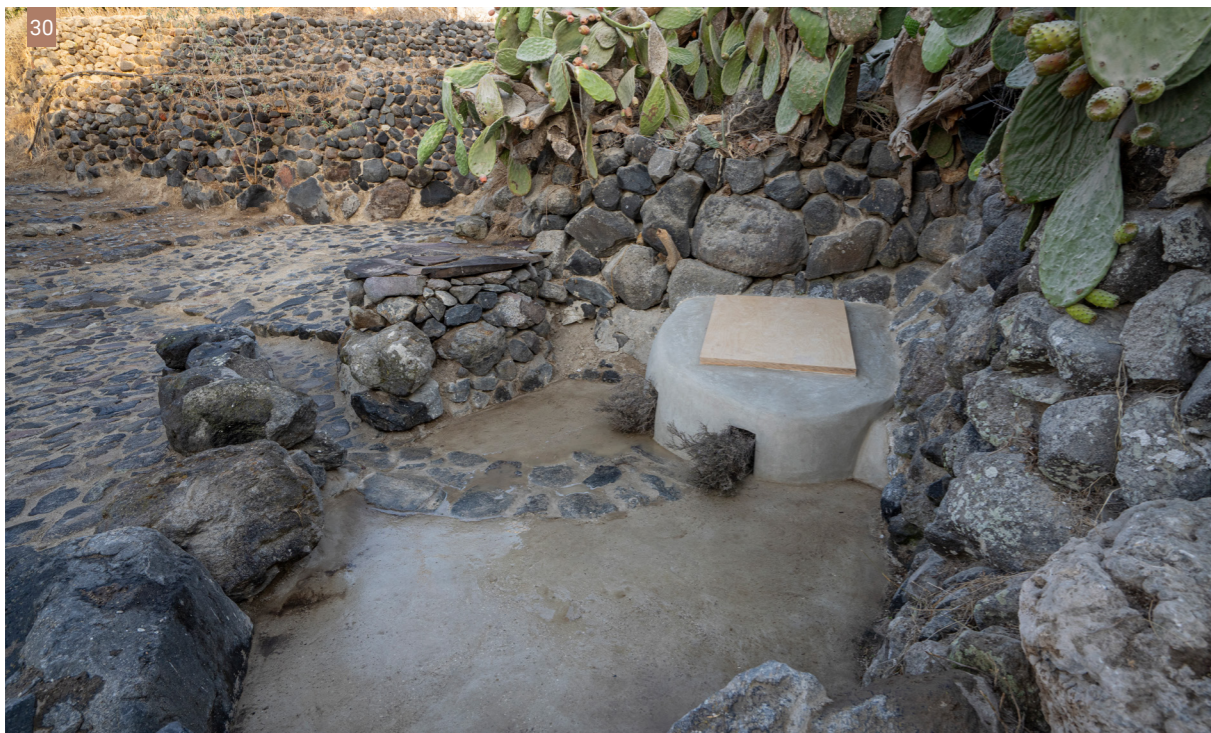
Εικ. 30| Η στέρνα Α και η διαμόρφωση της εξωτερικής επιφάνειας συλλογής του νερού, μετά την αποκατάσταση. (Φωτ: Γ. Κυβερνήτης)
