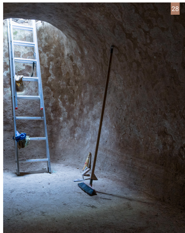
Εικ. 28| Η στέρνα Α μετά τις προκαταρκτικές εργασίες. (Φωτ: Γ. Κυβερνήτης)
