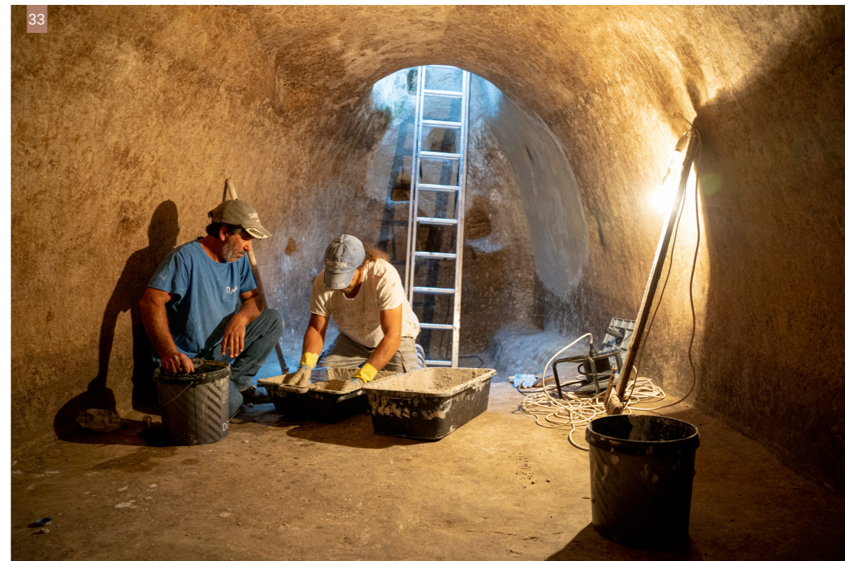
Εικ. 33| Η ανάμειξη και συντήρηση του αλείμματος γίνεται εντός της στέρνας, σε συνθήκες υψηλής υγρασίας. (Φωτ: Γ. Κυβερνήτης)
