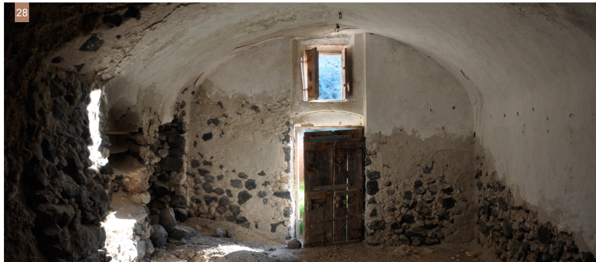
Εικ. 28, 29| Όψεις εξωτερικής και εσωτερικής επίχρισης υπόσκαφων κατοικιών. (Φωτ: Μ. Χασιώτη, Ι. Ντούση)
