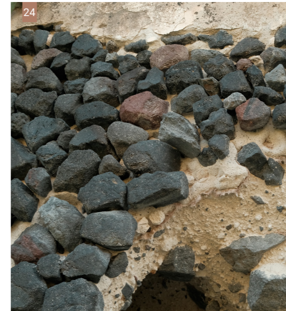
Εικ. 24, 25, 26| Λεπτομέρειες υπόσκαφων κατασκευών. Η δόμηση στηρίζεται στο ισχυρό κονίαμα άσπας-ασβέστη και επιτρέπει λιγότερη επιμέλεια στο χτίσιμο της πέτρας. (Φωτ: Ι. Ντούτση)
