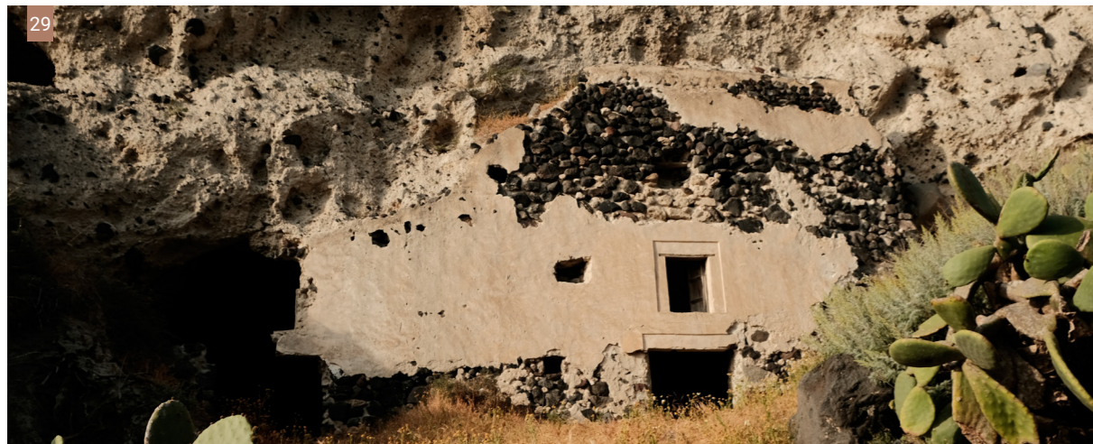
Εικ. 28, 29| Όψεις εξωτερικής και εσωτερικής επίχρισης υπόσκαφων κατοικιών. (Φωτ: Μ. Χασιώτη, Ι. Ντούση)
