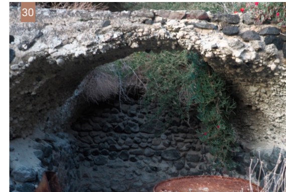
Εικ. 30, 31| Θολωτή κατασκευή στην Αγριλιά, με το τοπικό σκυρόδεμα, το κισσηρόδεμα. (Φωτ: Π. Κωστούλας, Γ. Κυβερνήτης)
