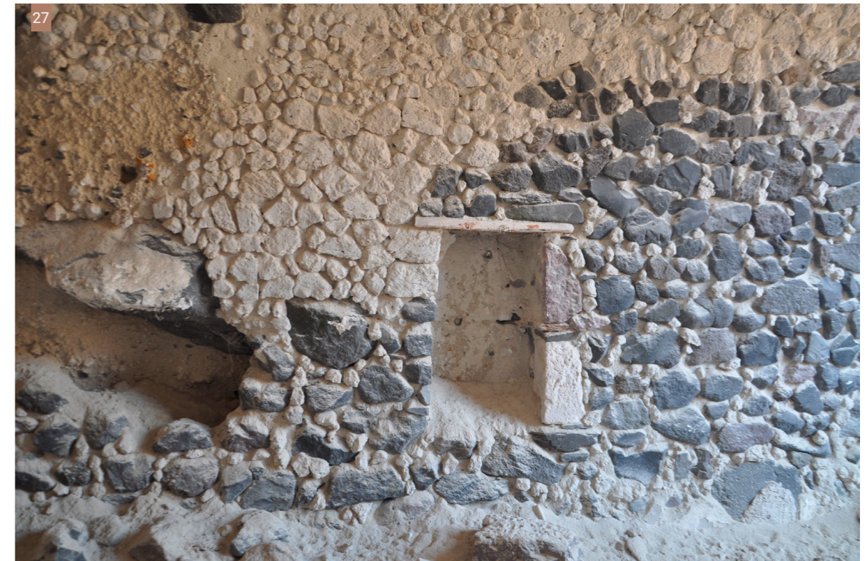
Εικ. 27| Η ελαφρόπετρα χρησιμοποιείται από ένα ύψος και πάνω στην κατασκευή για να μειώσει το συνολικό βάρος. (Φωτ: Ι. Ντούτση)
