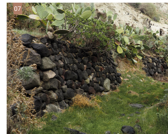
Εικ. 7| Ξερολιθικός τοίχος για τη διαχείριση του χώρου και του νερού στην Αγριλιά. (Φωτ: Γ. Κουτρόπουλος)
