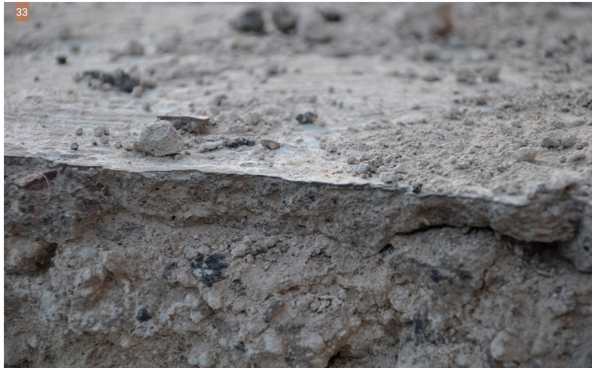
Εικ. 33| Λεπτομέρεια από επίστρωση πατητού κονιάματος σε δάπεδο υπόσκαφης κατοικίας στην Αγριλιά. (Φωτ: Μ. Χασιώτη)
