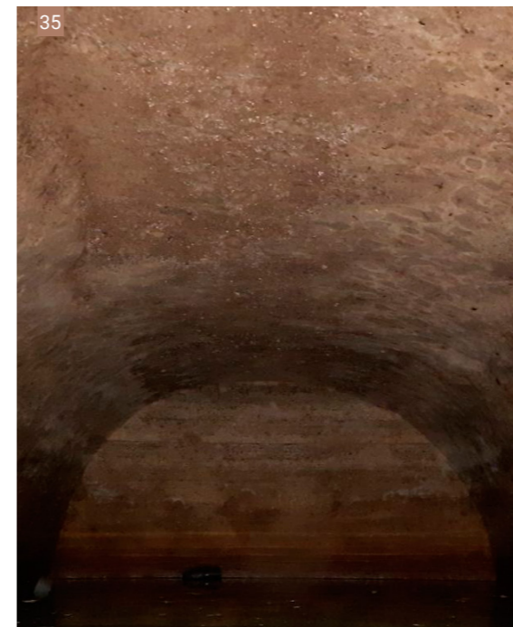
Εικ. 34, 35| Λεπτομέρειες από στεγανωτικό πατητό κονίαμα σε στέρνα του υπόσκαφου οικισμού της Αγριλιάς. Η ικανότητα της στέρνας να συγκρατεί νερό μέχρι και σήμερα αποδεικνύει τις στεγανωτικές ιδιότητες του υλικού, παρά την ελλιπή συντήρηση της κατασκευής. (Φωτ: Π. Κωστούλας)
