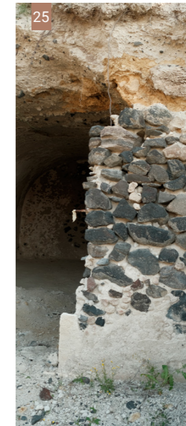
Εικ. 24, 25, 26| Λεπτομέρειες υπόσκαφων κατασκευών. Η δόμηση στηρίζεται στο ισχυρό κονίαμα άσπας-ασβέστη και επιτρέπει λιγότερη επιμέλεια στο χτίσιμο της πέτρας. (Φωτ: Ι. Ντούτση)
